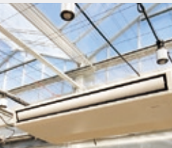
ヒートポンプ(5馬力×6台)
