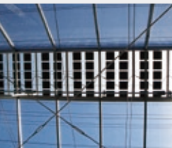
ハウス天窓部太陽光発電システム 7.84kW(35W×224枚)
